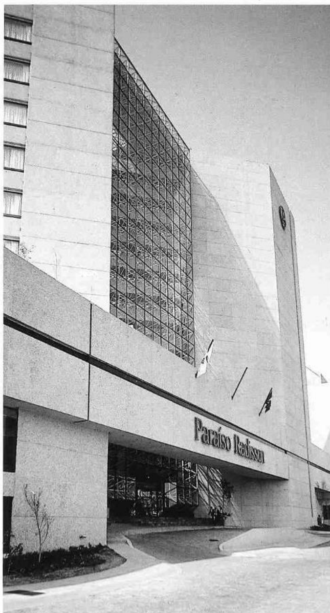
Aspecto de la fachada principal del hotel.
