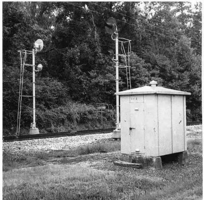
Vista de semáforos y casetas de señalización en Lorane.
